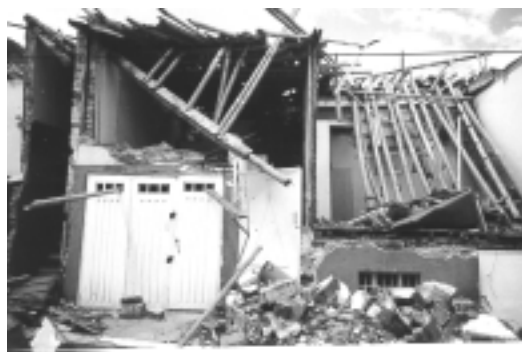
Abb. 12: Einstürztes Haus in Armenia, Kolumbien nach dem Erdbeben im Januar 1999.
