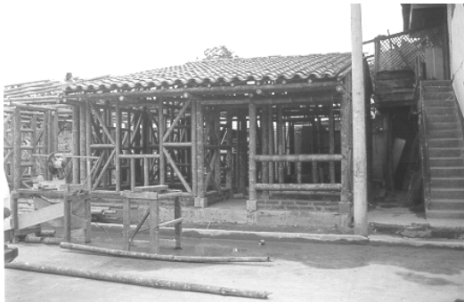
Abb. 14: Wiederaufbau eines erdbebenresistenten Hauses, Kolumbien im Juni 1999.
