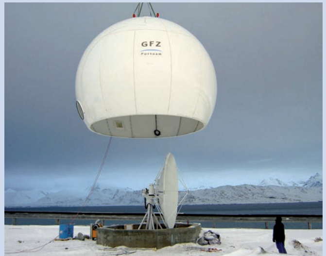
Die Satelliten-Empfangsstation Ny-Ålesund auf Spitzbergen
