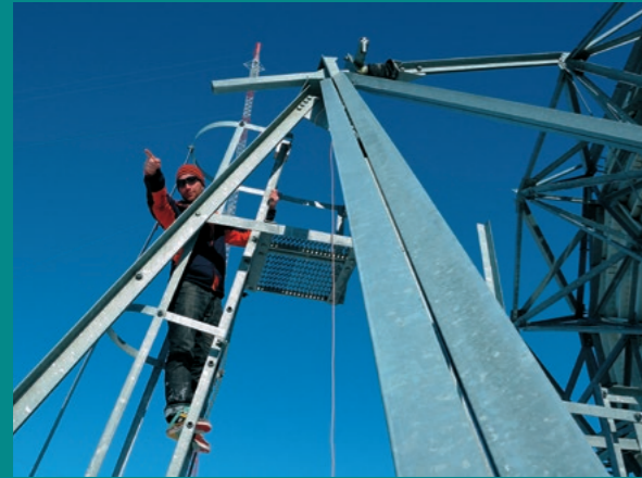
Auf dem Antennenturm kontrolliert Hennes Henniger das Sichtfeld der Antenne
