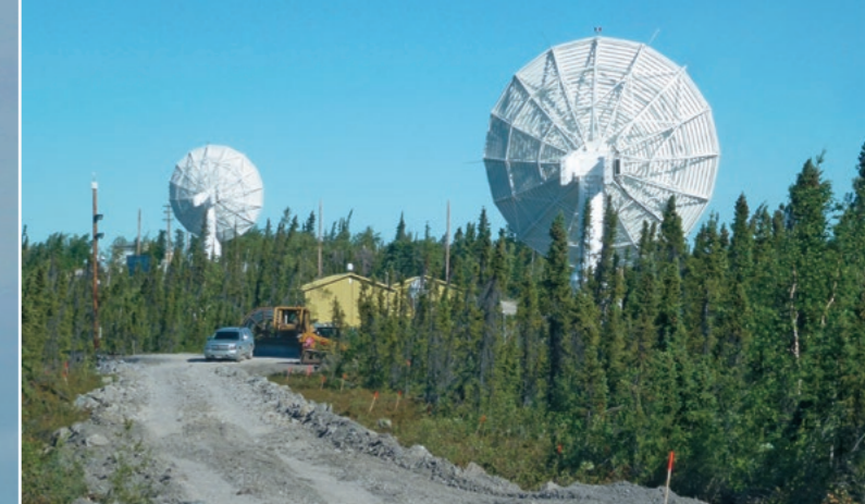
Eine staubige Schotterstraße führt zu den Kontrollhäuschen zwischen den Antennen
